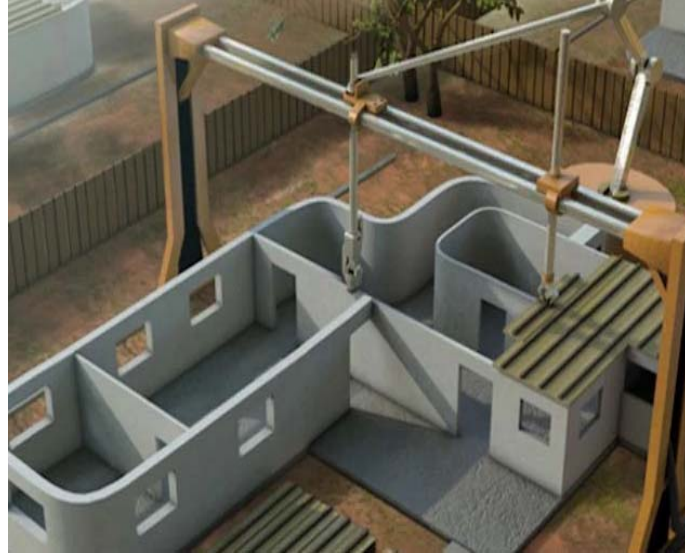
Şekil 2. 3 Boyutlu Beton Yazıcı Çalışma Örneği (3dprintingindustry, 2013)
