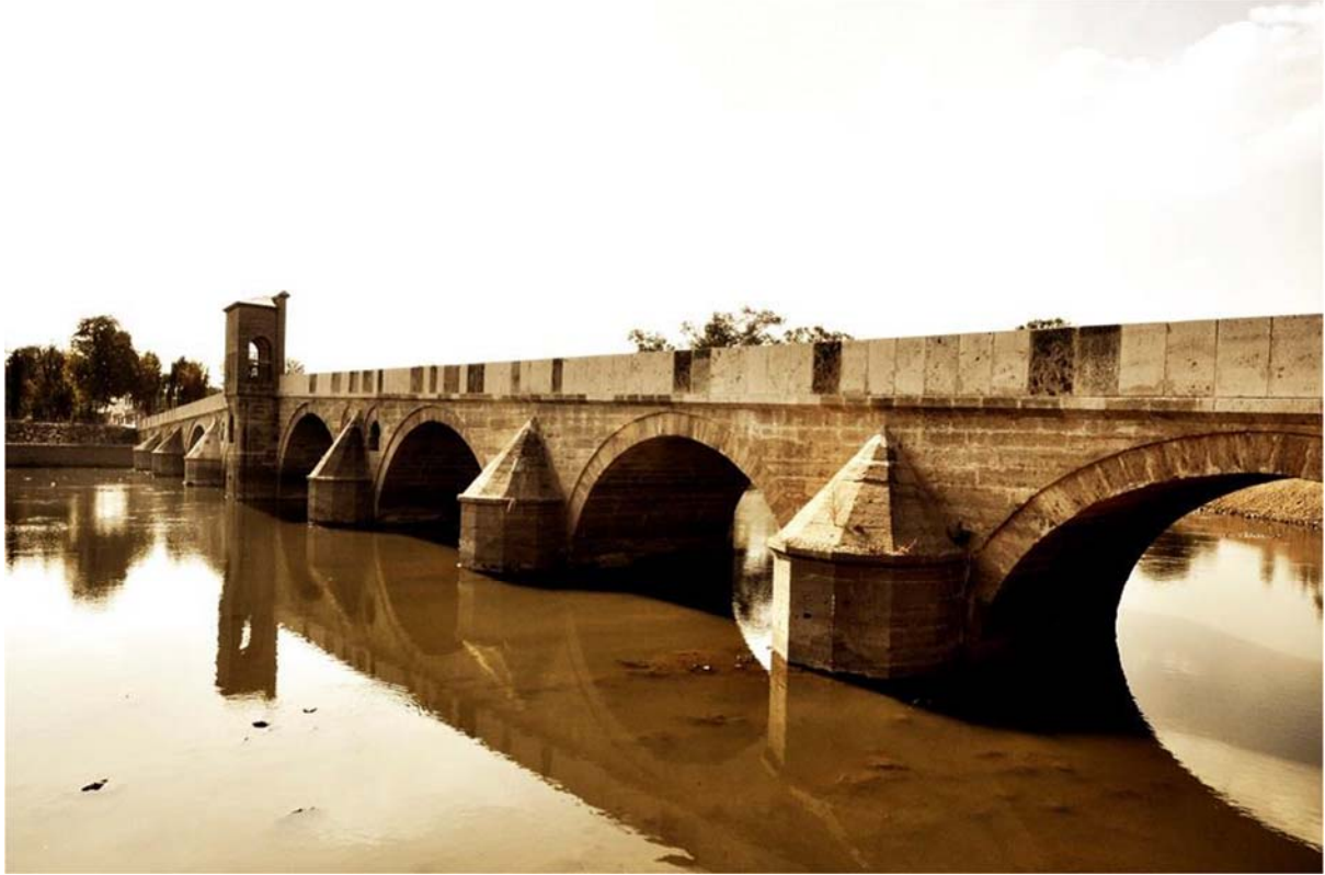
Şekil 5. Tunca Köprüsü, Edirne
